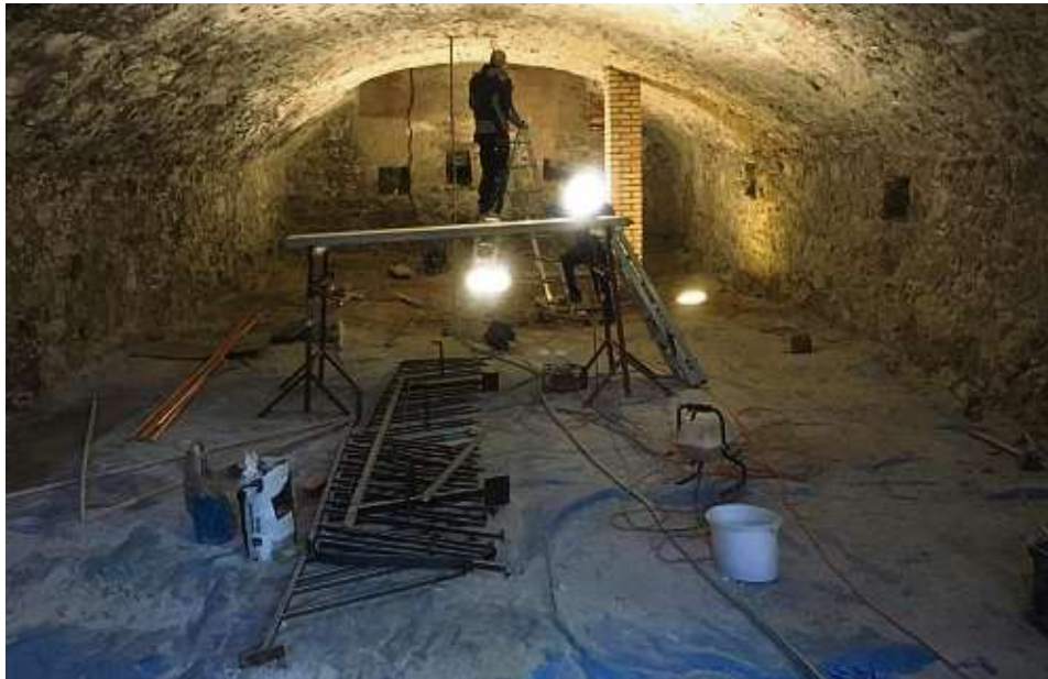
Ein Handwerker schaut sich das Gewölbe im Keller genauer an.
